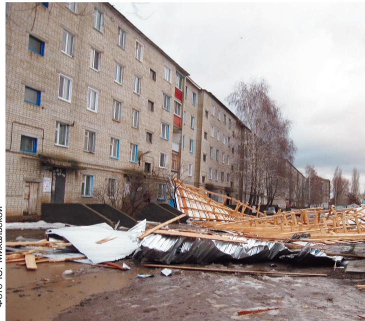
Так выглядел во вторник двор многоэтажного дома № 57 на проспекте Ленина. Снимок сделан через пару часов после обрушения кровельной конструкции
