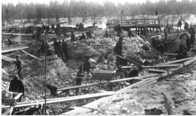
Строительство Беломорско-Балтийского канала, 1931-1933 гг. Фото с сайта: www.gorod.tomsk.ru
